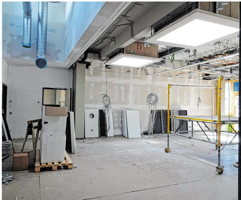
Der Vorbereitungsraum Chemie/Biologie im neuen Fachraumzentrum steht kurz vor Einbau der Möbel.
