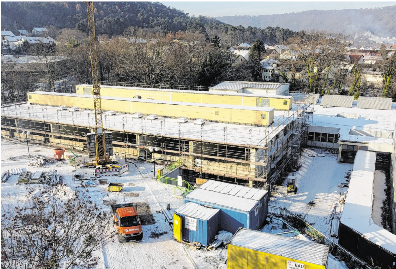
Die Generalsanierung des Berufschulzentrums Wertheim in Bestenheid ist eines der aktuell großen Vorhaben des Main-Tauber-Kreises.
