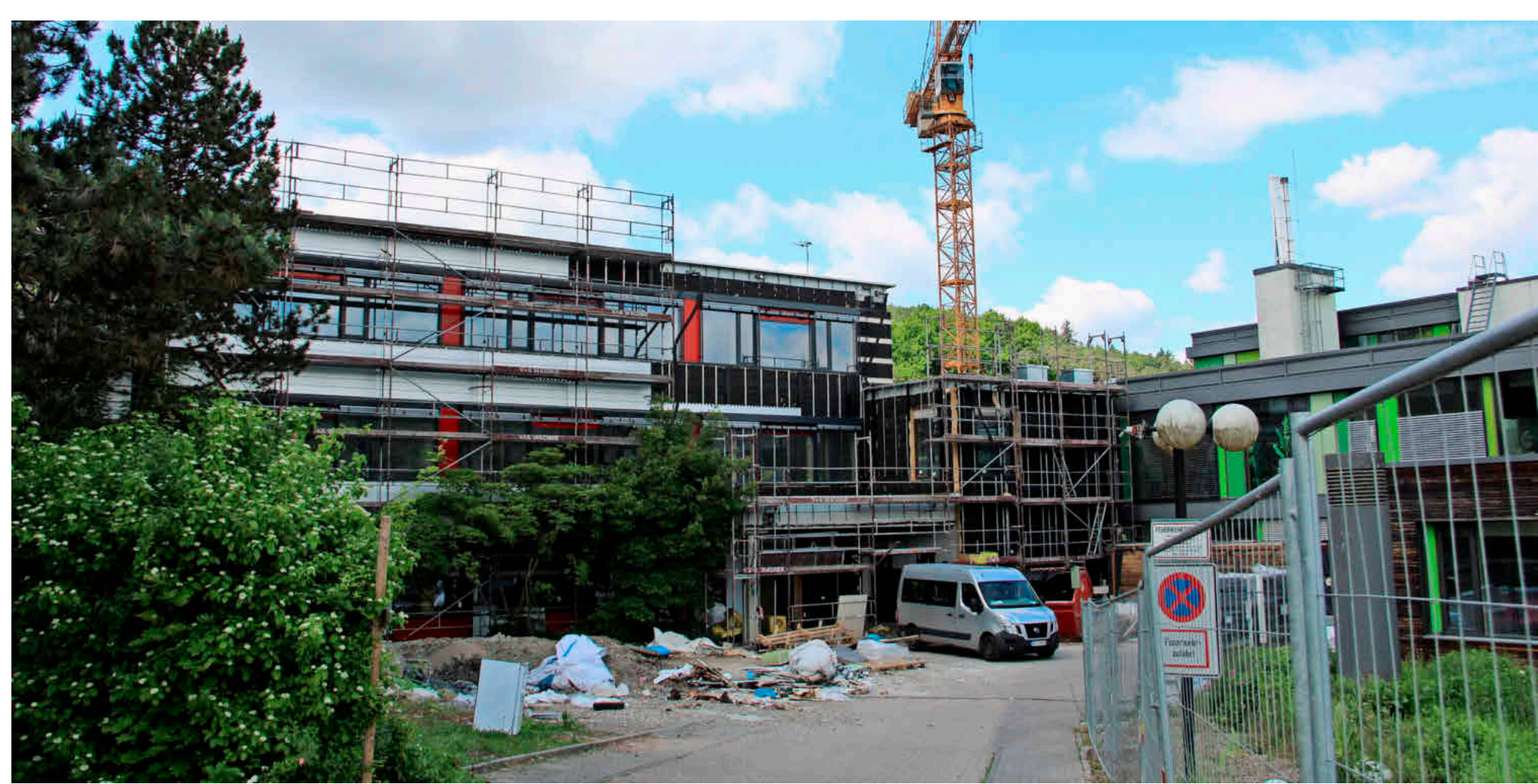
Das Berufliche Schulzentrum (BSZ) Wertheim in Bestenheid wird derzeit vom Landkreis saniert und erweitert. Der Kreistag beschloss jetzt einstimmig, den Bildungsgang AV-Dual in den kommenden drei Schuljahren am BSZ fortzusetzen.
